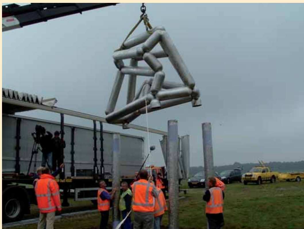
Plaatsing kunstwerk N381
