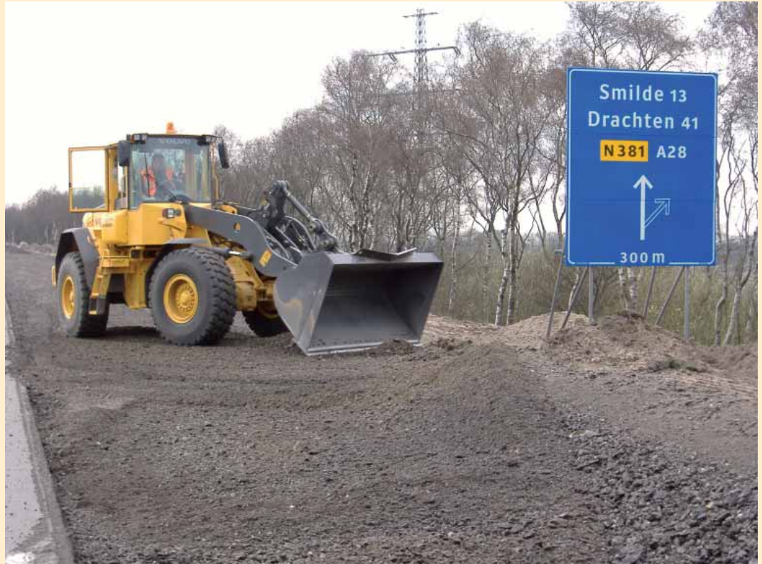
Aanleg N381 Beilen- Westerbork
