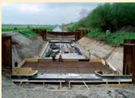
Onderhoud aan het Erica-Ter Apel kanaal
