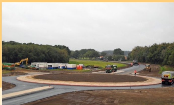
Aanleg rotonde Pesse.
