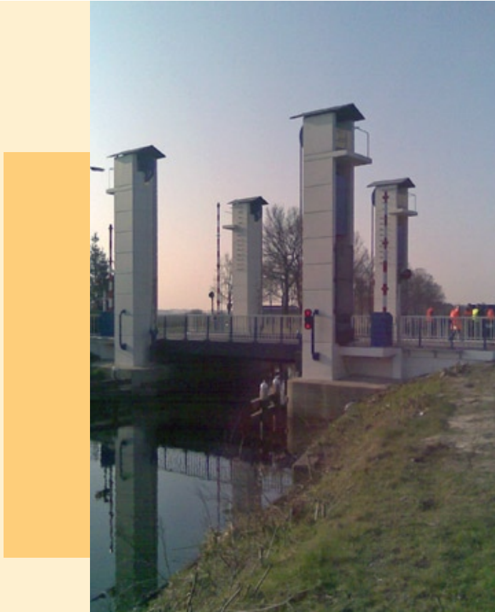
De gerenoveerde Viertorenbrug in de vaarweg Erica-Ter Apel.
