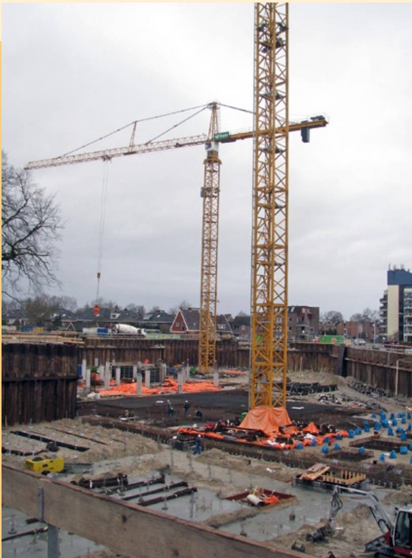
Cultureel Kwartier Assen in aanbouw
