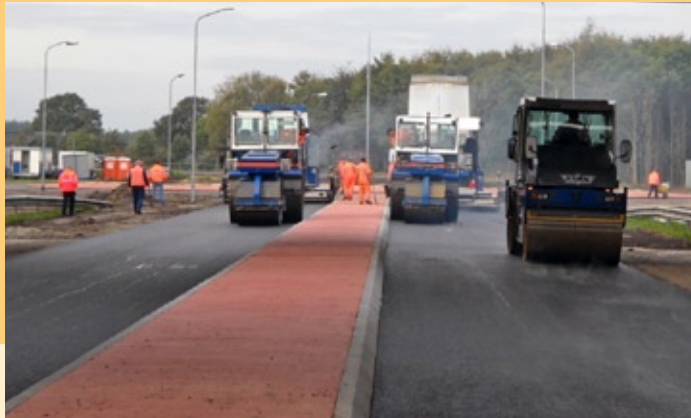
Aanleg rotonde Pesse.
