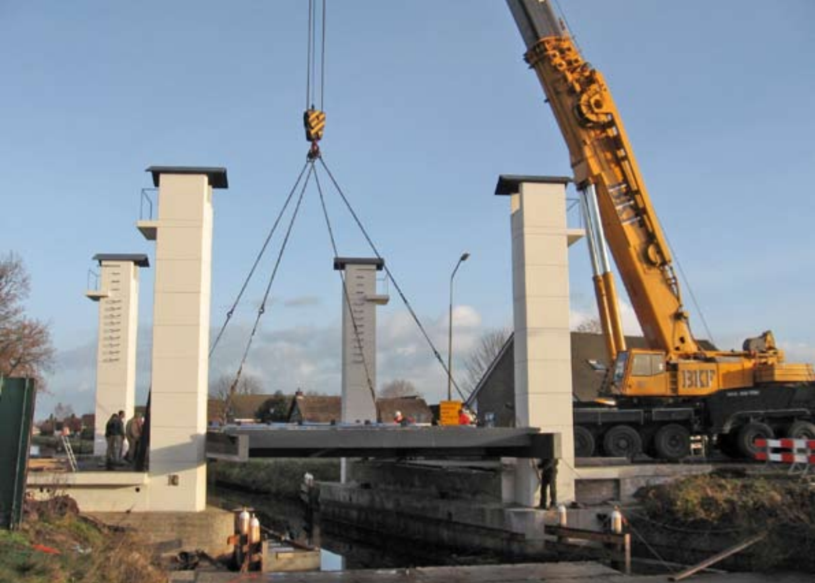
Aanleg nieuwe brug in het kanaal Erika-Ter Apel
