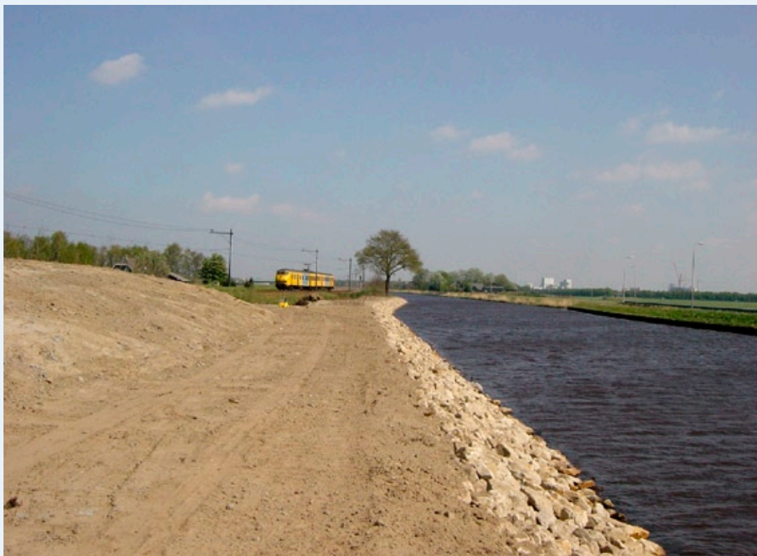
Verbreding en met milieuvriendelijke oevers afwerken van het Coevorden-Vechtkanaal.
