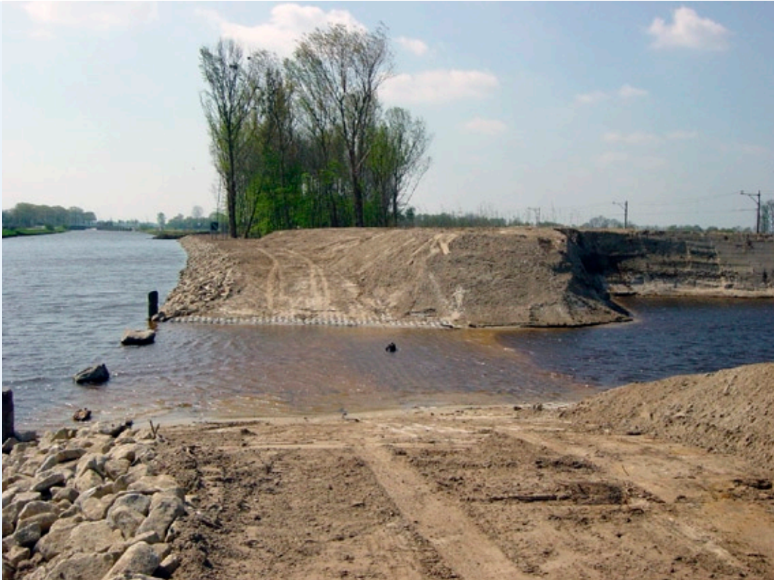
Aangelegde poel met een aangebrachte wand voor oeverzwaluwen
