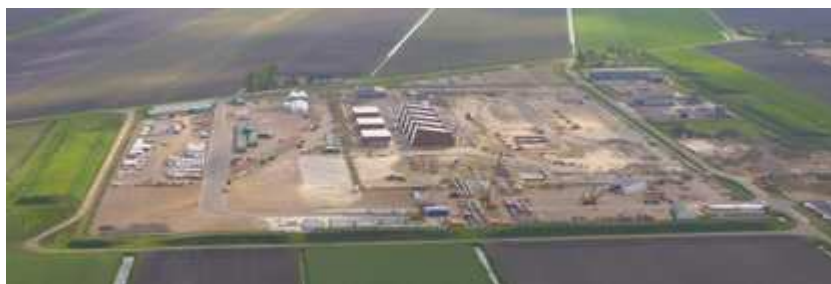
Bouwproces Zuidwending (Bron: www.Nuon.nl )
