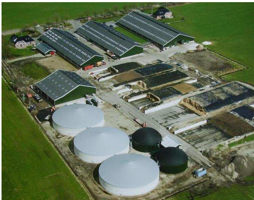
Vergistingsinstallatie op boerderijschaal; www.hoSt.nl
