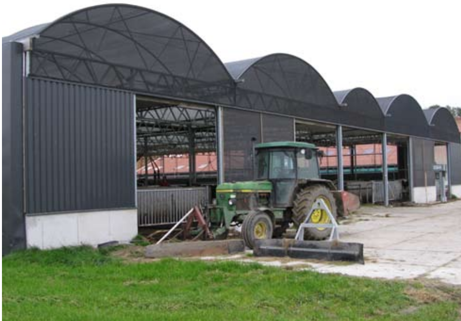
In de kopgevel aan de achterkant van de stal valt het verschil in de maatvoering van de middelste boog op. Onder deze boog loopt de relatief smalle voergang.
