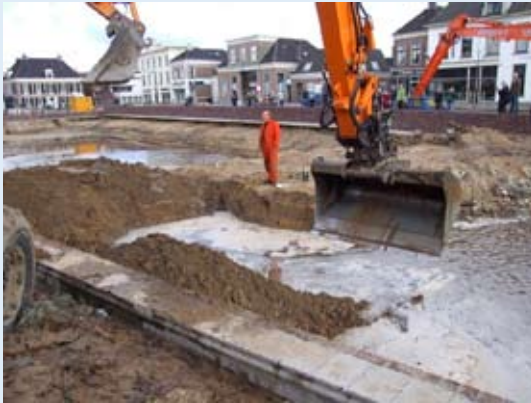
Sanering t.p.v. de Kolk en het doorsteken van de dam in Assen. Bron: gemeente Assen
