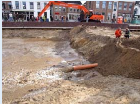
Sanering t.p.v. de Kolk en het doorsteken van de dam in Assen.
