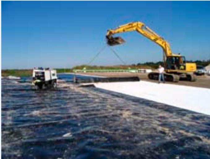
Afdekken gesloten stort te Ubbena
