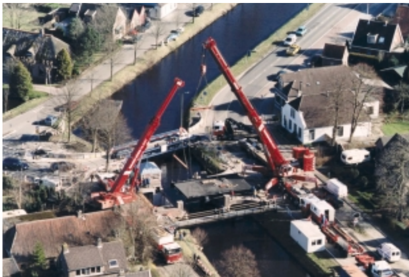
Plaatsen van de nieuwe Norgerbrug
