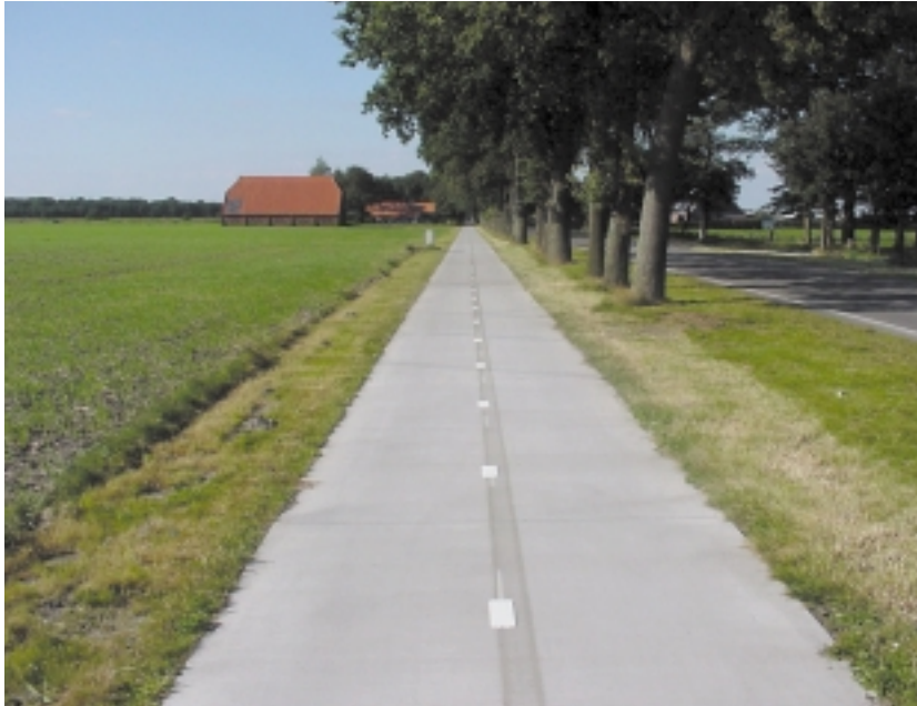
F376: Nieuw betonnen fietspad tussen Schoonoord en Noord-Sleen
