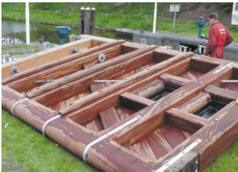
Oranjesluis: De bovendeuuren zijn vervangen door twee nieuwe deuren
