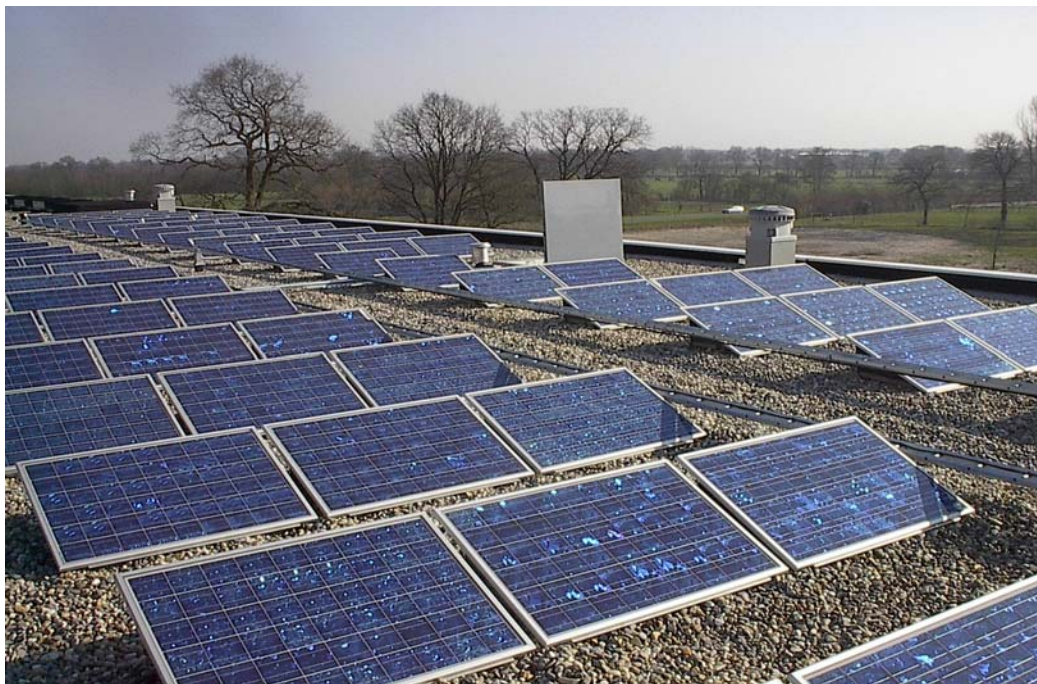
Dak van het nieuwe gemeentehuis van Tynaarlo te Vries. Bij de bouw van het gemeentehuis zijn diverse dubo-maatregelen genomen waaronder het toepassen van zonnecollectoren.
