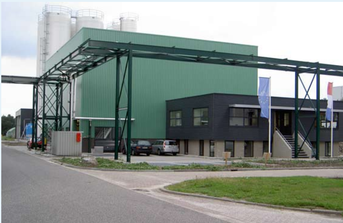
Fabriek Sunoil Biodiesel BV in aanbouw.
