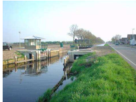
Sluis Emmer Compasuum zuid. Vanuit het wachthuisje wordt vanaf juni 2010 de bediening via begeleide vaart geregeld.
