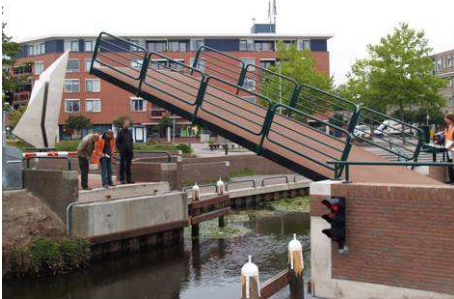
In het centrum van Emmer Compascuum is een nieuwe, zogenaamde klapbrug gebouwd.
