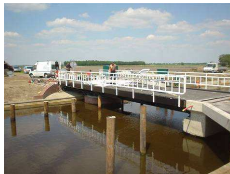
Op het traject Munnikemoer- Emmer Compasuum liggen nu 3 draaibruggen. Bovenstaande brug is een nieuw aangelegde draaibrug. Bij het ontwerp is gekeken naar de voorheen aanwezige bruggen
