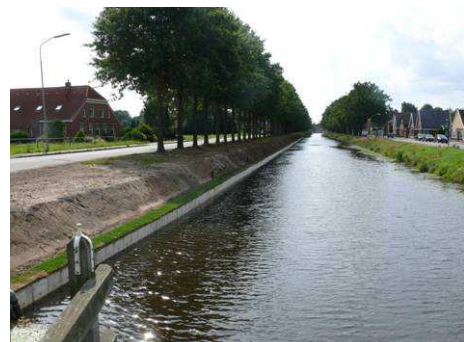
De betonnen oeverconstructie in het centrum van Emmer Compascuum
