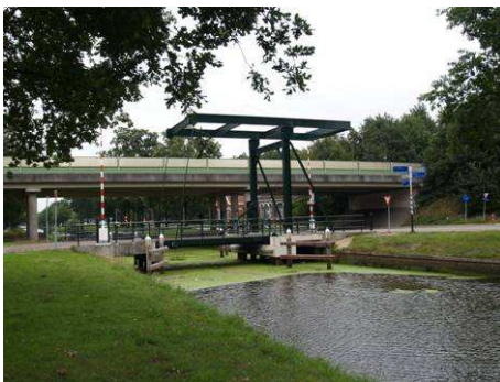
Brug de Maten bij Ter Apel is compleet vernieuwd. Door de bredere en zwaardere bouw van het val is de brug geschikt voor het zwaardere verkeer. De uitstraling van de brug is gelijk gebleven.
