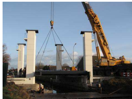
Het vaste dek van de Viertorenbrug is vervangen door een hefbaar stalen dek.
