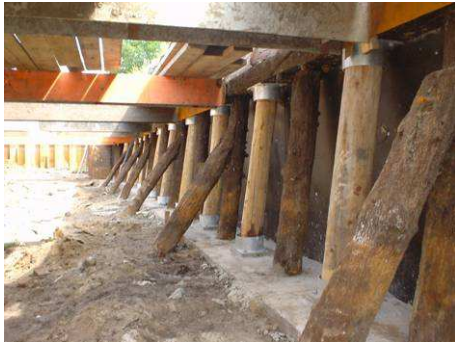
Sluis bij Viertorenbrug tijdens de renovatie. Oude (ca. 1890) en nieuw aangebrachte funderingspalen ter ondersteuning van de sluiswand.
