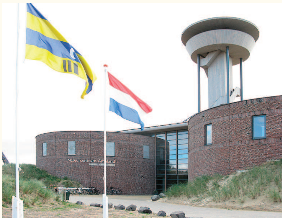
Energieproject Kenniscentrum, Ameland EOGFL/Leader+ bijdrage € 146.604,-
