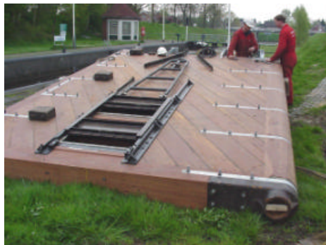
Oranjesluis: vervangen houten bovendeuren
