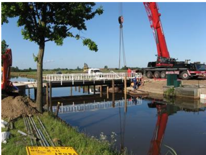
Aanleg nieuwe draaibrug tussen Ter Apel en Emmer-Compasuum.
