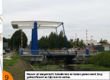
8 Bestaande draagbrug geëlektrificeerd.
