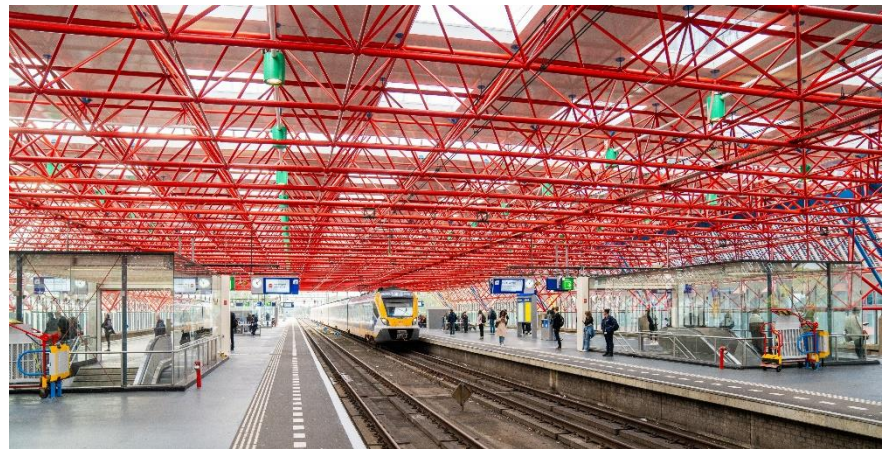
Station Almere Centrum is heropend, waarbij de perronkappen volledig zijn gerenoveerd en al het glaswerk is vervangen met glas waar grotendeels zonnecellen in verwerkt zijn.
