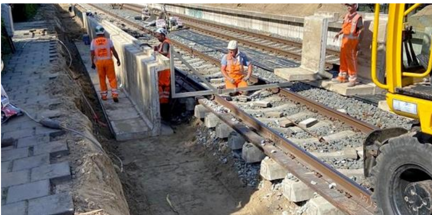
Meerdere perrons werden op hoogte gebracht.
