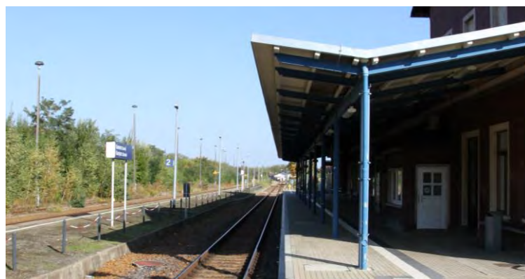
Abb. 3-4 Bahnsteigdach im Lichtraumprofil des Stromabnehmers (Foto: Wittemann)
