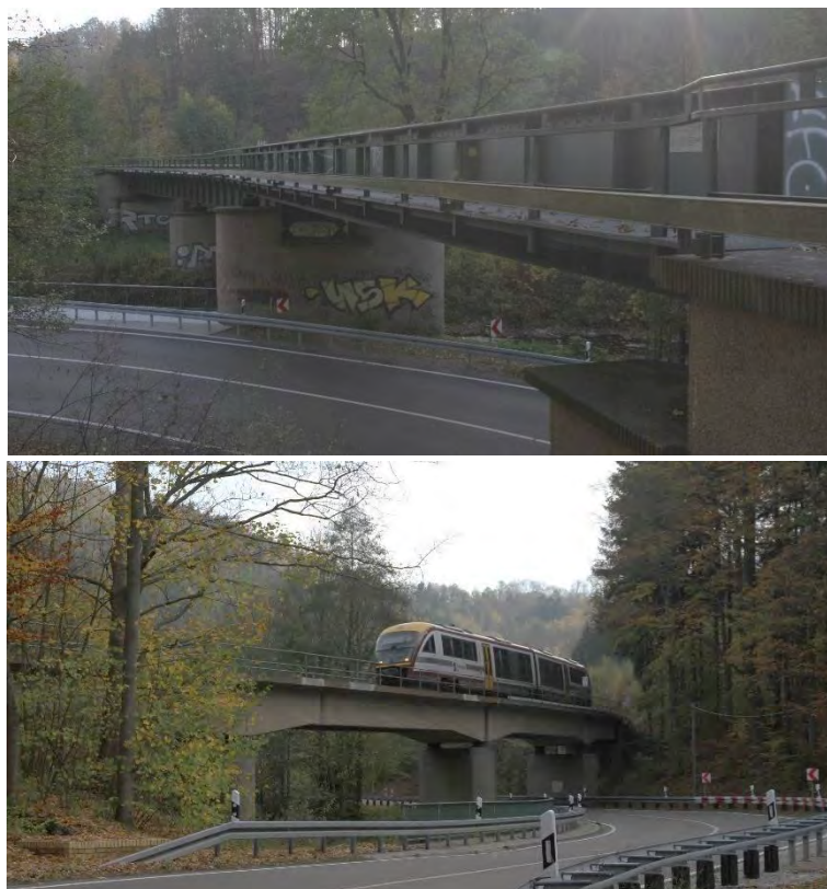
Abb. 3-7 Beispiele zu prüfender Brücken: genietete Stahlträgerbrücke (oben) bzw. alte Betonbrücke aus den 1930er Jahren (unten)
