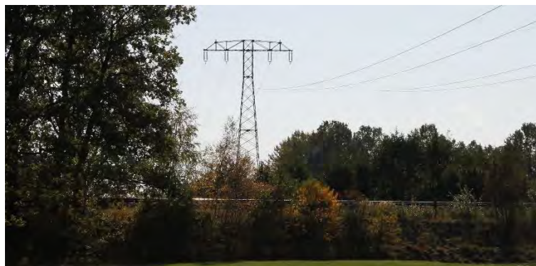
Abb. 3-9 Mast einer 110-kV-Bahnstromleitung (Foto: Wittemann)
