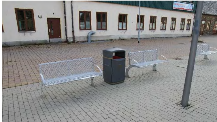
Abb. 3-2 Nicht mit der Rückleitung verbundene Bahnsteigmöblierung (Foto: Wittemann)
