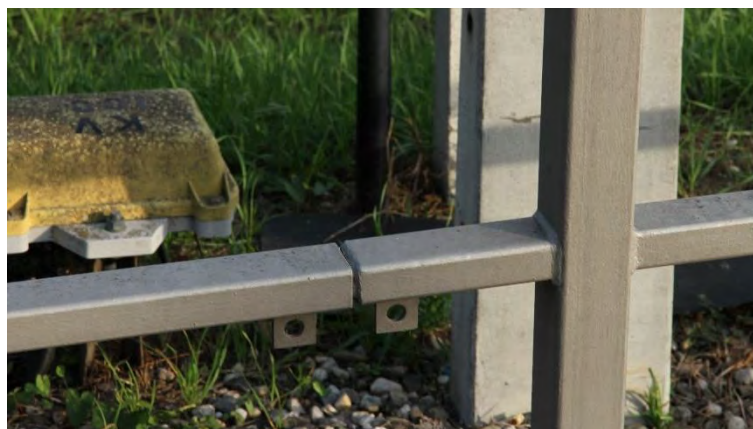
Abb. 3-3 Geländer ohne Längsverbindung, jedoch mit hierfür vorgesehenen Laschen (Foto: Wittemann)
