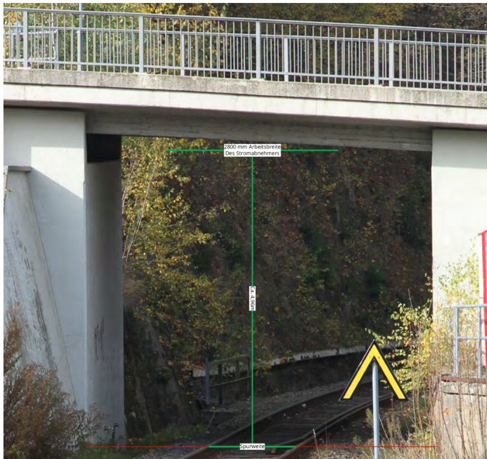
Abb. 3-5 beispielhaftes Brückenbauwerk (Foto & Grafik: Wittemann)
