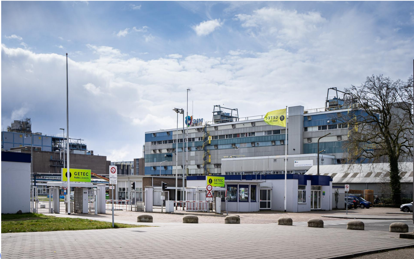
Maatwerkfinanciering: Paques Biomaterials (Biopolymeren pilotfabriek op GETEC-terrein in Emmen)
