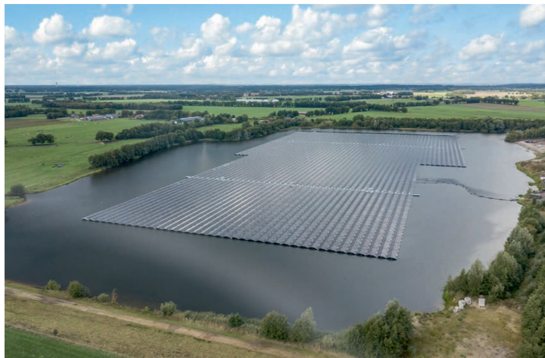
Combineren van functies (zandafgraving en zonnepark De Mussels)
