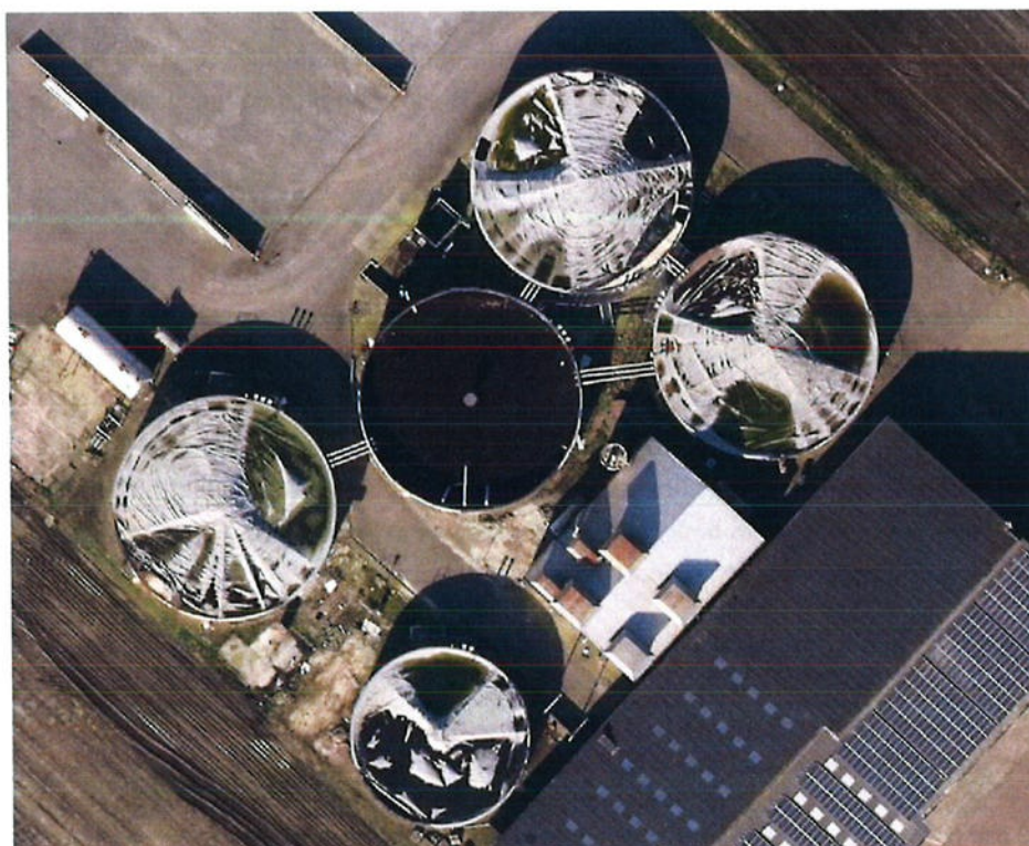
Figuur 4. 5 jaar + in onbruikzijde onderzochte installatie
