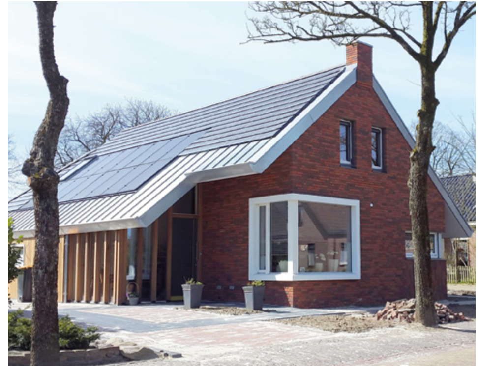
Sloop/nieuwbouw karakteristieke gebouwen. ▼
