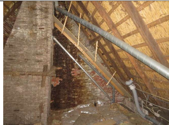
afbeelding 13: Situatie aan de binnenzijde van de achtergevel. Foto genomen vanaf de zolderverdieping.
