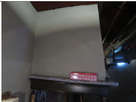
afbeelding 91: Doorhangende schouw.
