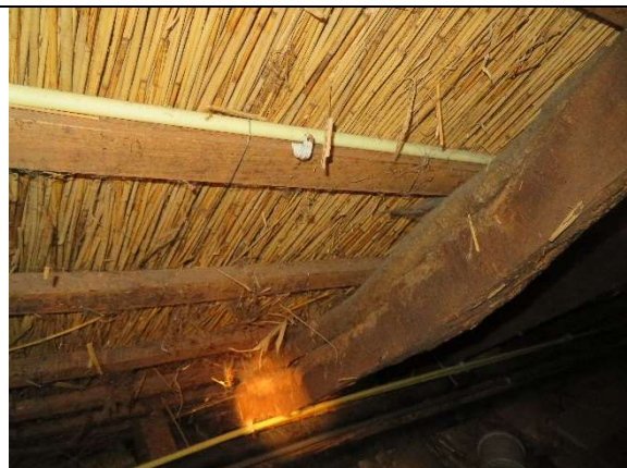
afbeelding 88: situatie linker dakschild. Herstel noodzakelijk.
