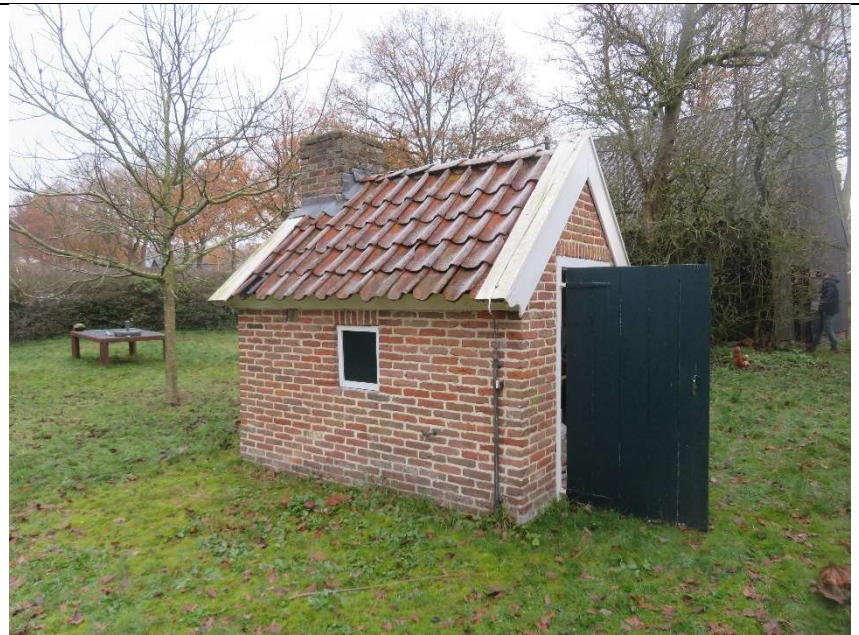
afbeelding 139: Linker zijgevel (Zuidzijde) en achtergevel (Westzijde)
