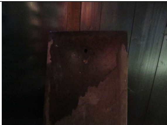
afbeelding 56: Onderzijde vloerluik nat.
