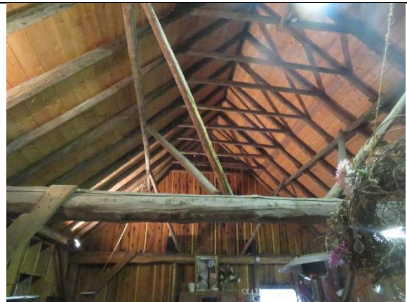
afbeelding 131: Situatie binnenzijde. Foto richting linker zijgevel.
