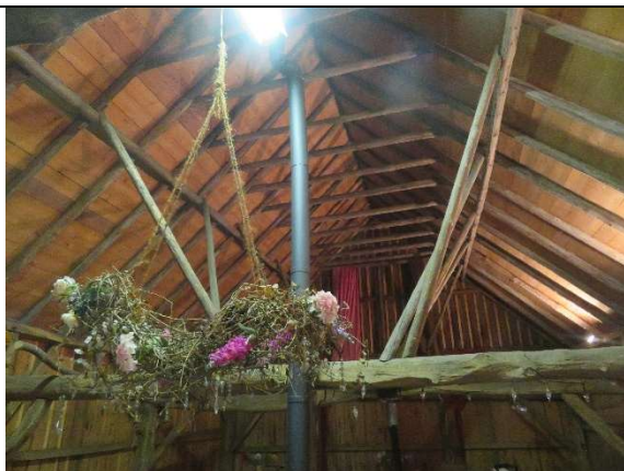
afbeelding 136: Situatie binnenzijde. Foto richting rechter zijgevel.
