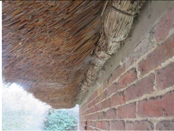
afbeelding 40: Aansluitdetail op buitengevel.
