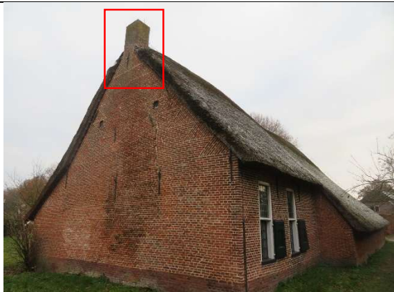
afbeelding 44: Gemetselde schoorsteen op topgevel achterzijde.
