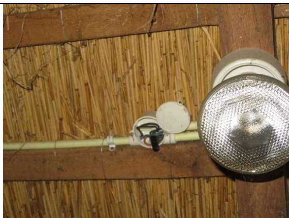
afbeelding 110: Voor zover te beoordelen is er geen sprake van oude jutebedrading maar van vinylbedrading. Foto genomen op de zolderverdieping.
