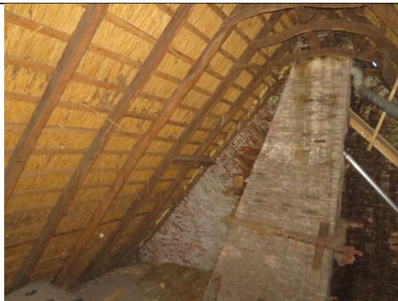
afbeelding 89: Schoorsteenkanaal ter plaatse van de achtergevel.
