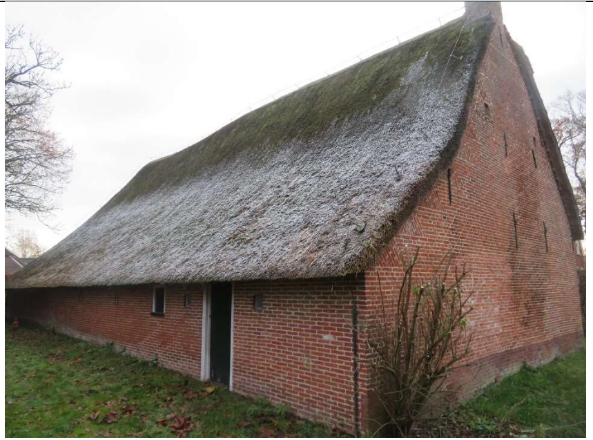
afbeelding 4: Achtergevel (Westzijde) en rechter zijgevel (Noordzijde)
