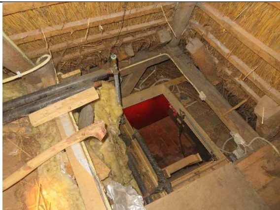
afbeelding 64: Zolderverdieping bereikbaar via een houten vlizotrap. Foto genomen richting hoek voorgevel/rechter zijgevel.
