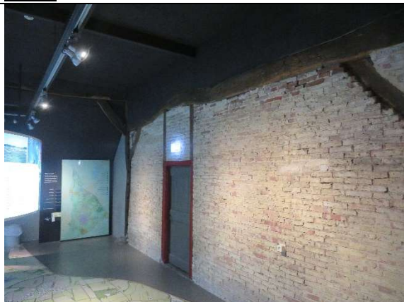
afbeelding 70: Binnenwand tussen ontmoetingsruimte /achterhuis.
