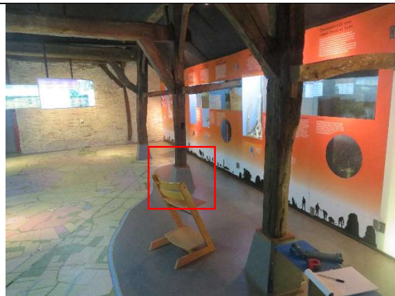
afbeelding 51: Situatie in de ontvangstruimte. Foto richting de rechter zijgevel.
