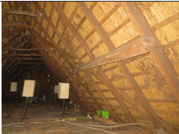
afbeelding 85: situatie ter plaatse van rechter dakschild. Foto richting achtergevel.
