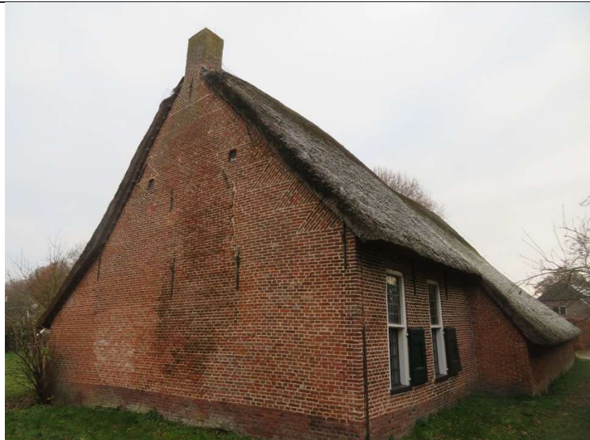
afbeelding 3: Linker zijgevel (Zuidzijde) en achtergevel (Westzijde).
