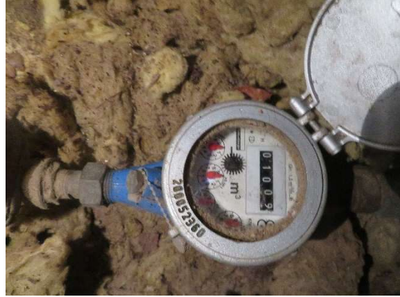
afbeelding 59: Close-Up watermeter.
