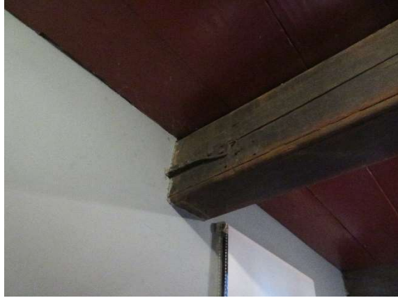
afbeelding 68: Verankerde balklaag zolderverdieping. Foto genomen vanaf begane grond (achterhuis).
