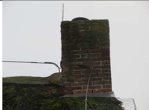
afbeelding 39: Situatie nokafwerking in aansluiting met de gemetselde schoorsteen.
