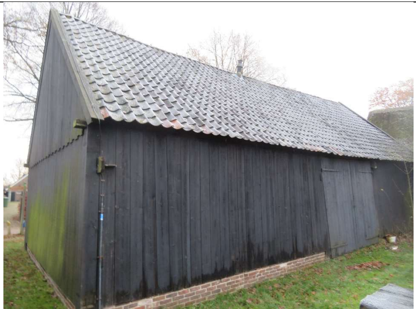
afbeelding 120: Achtergevel (Westzijde) en rechter zijgevel (Noordzijde).
