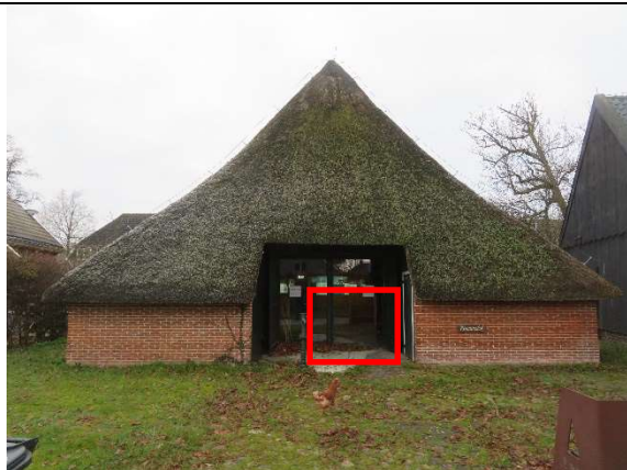
afbeelding 20: isolerende beglazing in de voorgevel Beglazing: 12 maart 2009.
