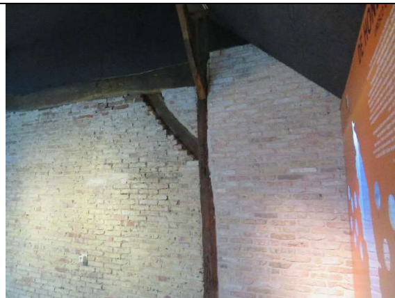
afbeelding 71: Binnenwand tussen ontmoetingsruimte /achterhuis.
