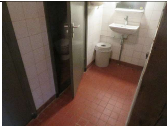
afbeelding 93: Sanitair in toiletruimte voorzijde.
