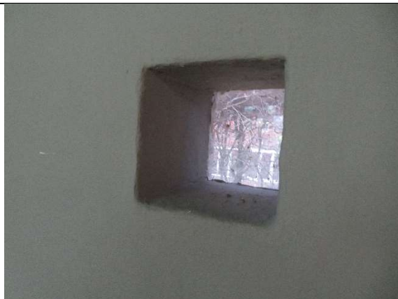
afbeelding 22: enkele beglazing in linker zijgevel.
