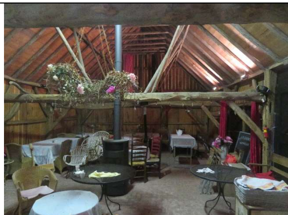
afbeelding 137: Situatie binnenzijde. Foto richting rechter zijgevel.
