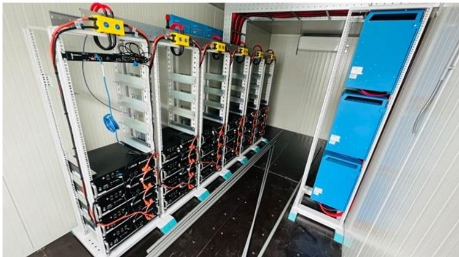
Energielening Plus: VOF Bouwhuis Meilink, energieopslag/accupakket (44 accu's, ca. 8.800 kW)
