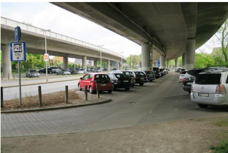
Abbildung 21: P&R-Platz Landwehrstraße an der BAB A28 Quelle: ISUP GmbH 2022
