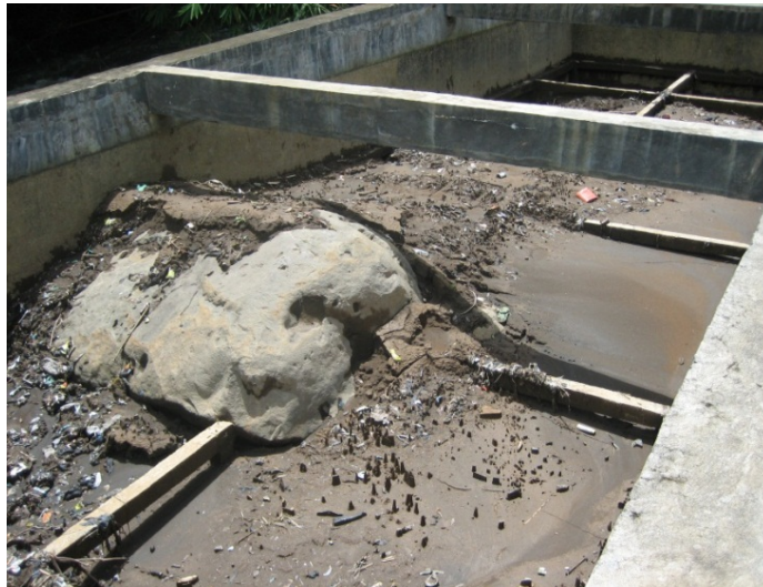
Voor de renovatie van 2009-2010
