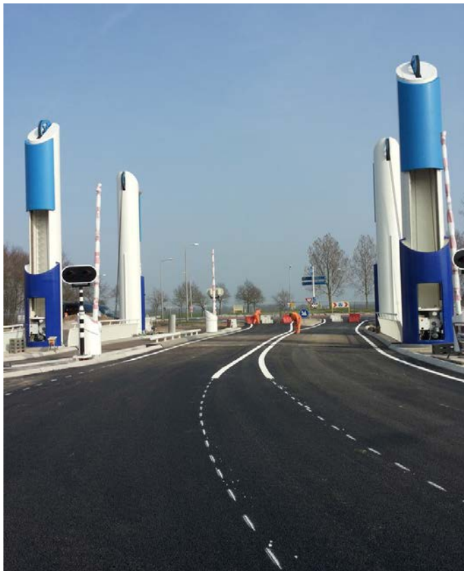
In 2015 oplevering Pijlebrug over Drentsche Hoofdvaart
