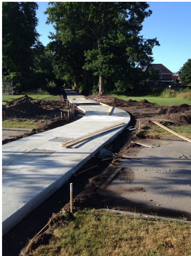
Fietspad naar Hof van Saksen in aanleg
