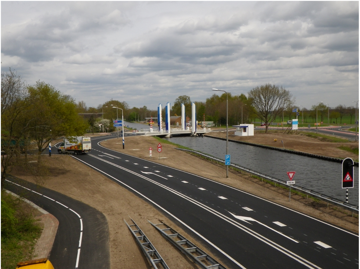
N371 Nieuwe Pijlebrug en reconstructie aansluitende infrastructuur
