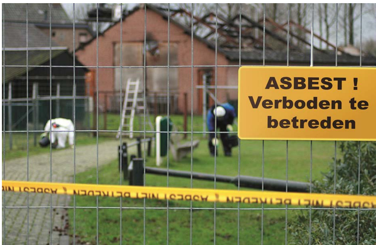
Saneren asbestdaken veiligheidsmaatregelen omgeven (foto: LTO)
