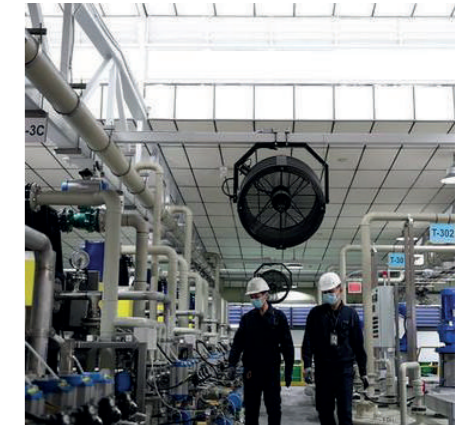
Batterijfabriek TES in Rotterdam
