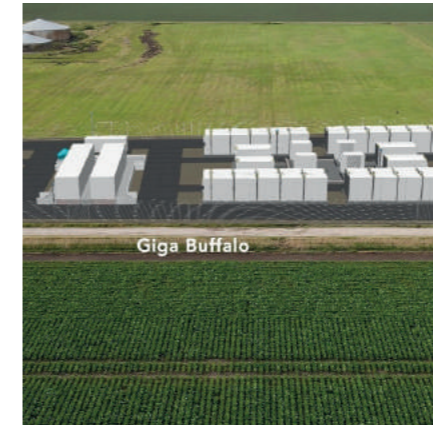
Eneco en GIGA storage energieopslag in Lelystad
